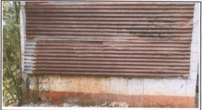
Foto 2: sustitucion de muro de lamina por muro de block.
